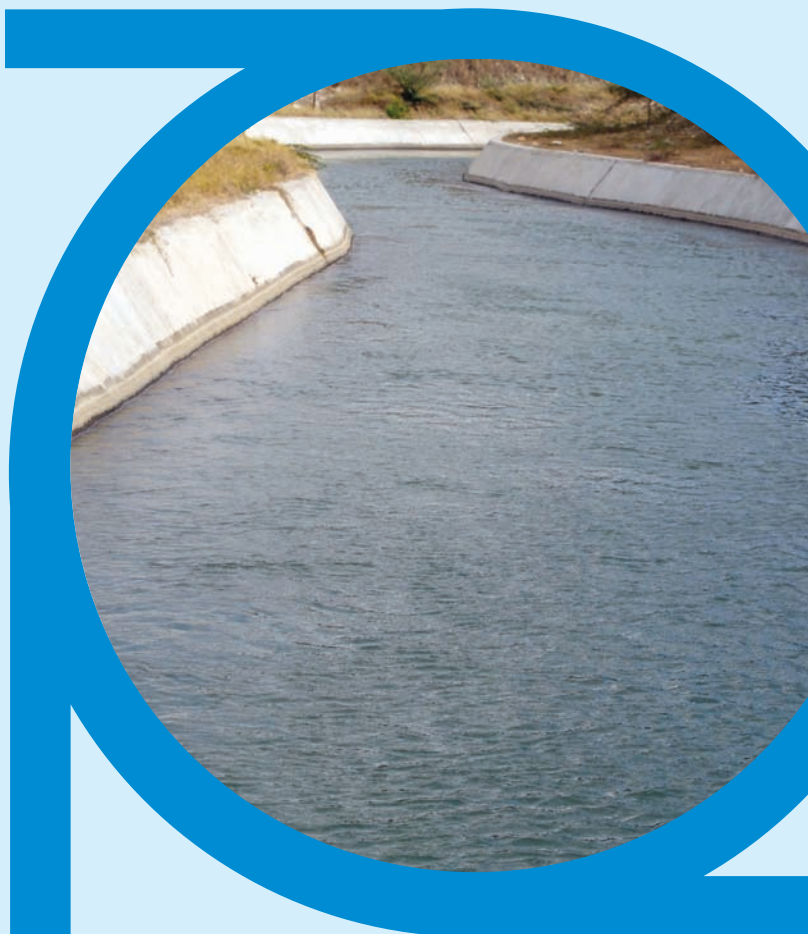
El Canal Ysura, de Azua, será ampliado dentro de los trabajos de Proyecto de Riego Azua II para integrar nuevas áreas a la agricultura sostenible.
