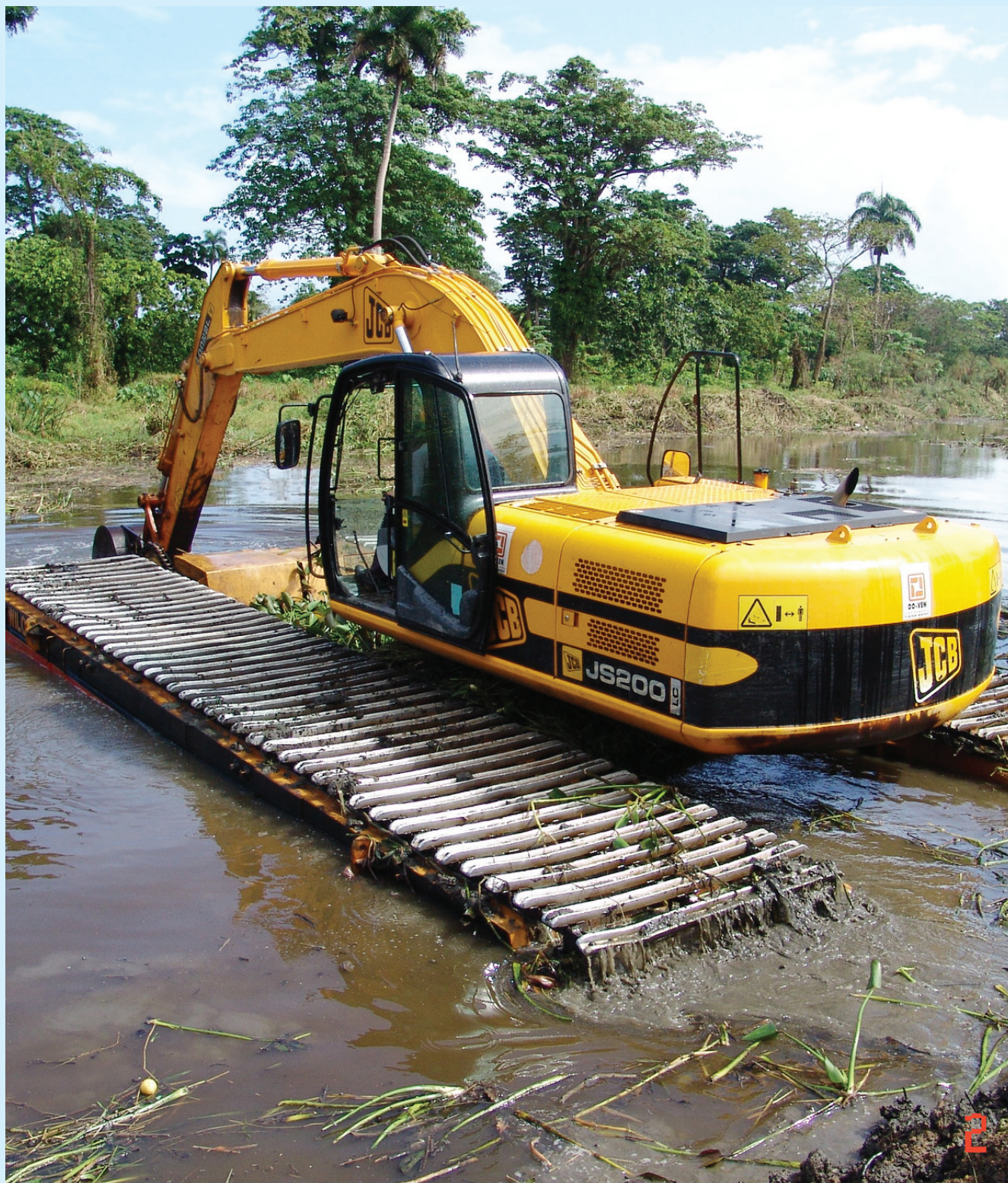
Durante 2006 el INDRHI invirtió más de RD$ 22.1 millones en la Rehabilitación y limpieza de sistemas de riego. En la foto, un anfibio realiza trabajos en Aglipo II.
