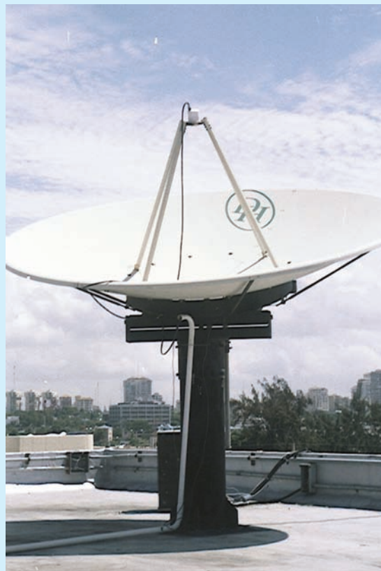
Parábola del sistema telemétrico satelital instalado por el INDRHI en su sede de Santo Domingo para recolectar, almacenar y procesar datos sobre cuestiones climáticas en el país.
