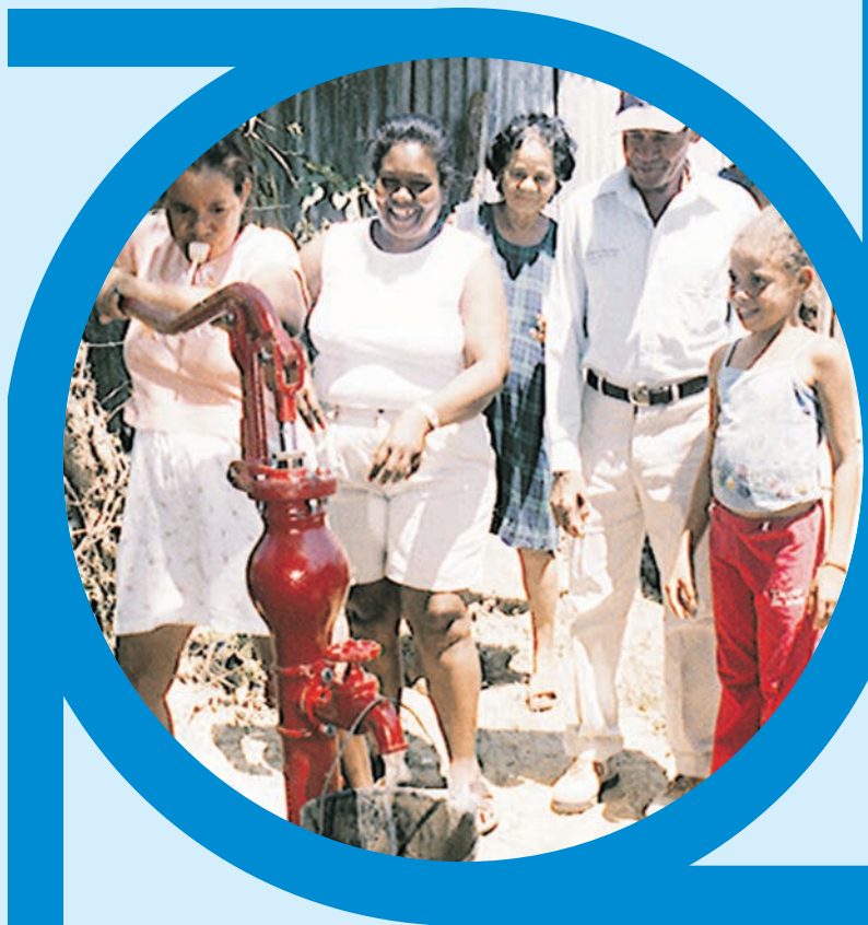
Con la instalación de Malacates, dentro del Programa Soluciones Rurales, el INDRHI ha dotado de agua potable a pequeñas poblaciones donde resulta difícil la construcción de un acueducto convencional.
