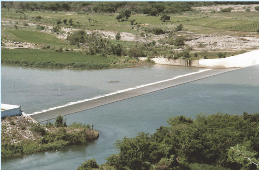
Las obras complementarias de la Presa derivadora de Villarapando eliminan los riesgos de vulnerabilidad y mantiene la seguridad de irrigación en las áreas bajo su influencia.
